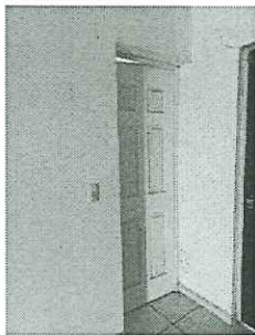
Acceso a la bodega electoral
