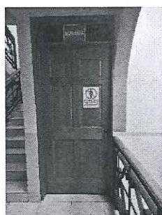
Acceso a la bodega electoral
