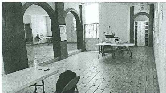
Acceso a la bodega electoral
