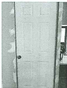
Acceso a la bodega electoral
