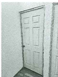
Acceso a la bodega electoral
