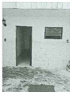
Acceso a la bodega electoral
