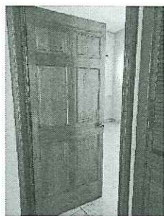
Acceso a la bodega electoral
