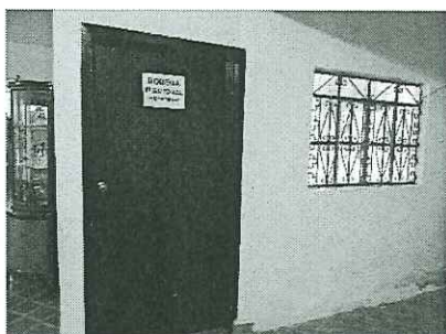
Acceso a la bodega electoral
