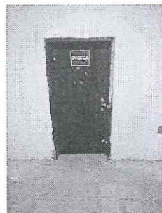
Acceso a la bodega electoral
