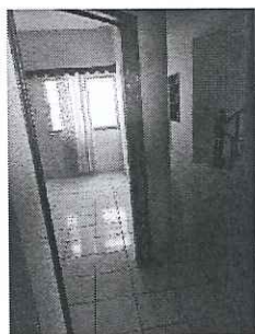
Acceso a la bodega electoral
