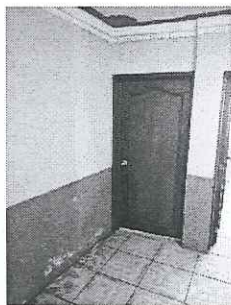
Acceso a la bodega electoral
