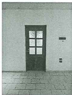
Acceso a la bodega electoral
