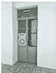
Acceso a la bodega electoral
