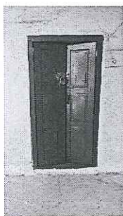
Acceso a la bodega electoral
