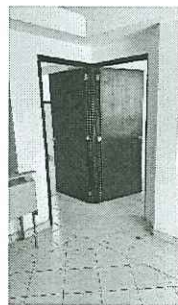
Acceso a la bodega electoral
