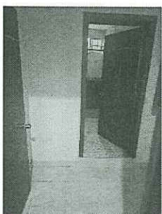
Acceso a la bodega electoral
