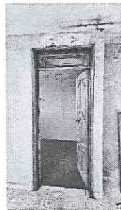
Acceso a la bodega electoral
