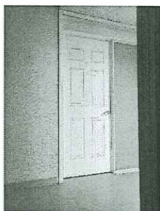
Acceso a la bodega electoral
