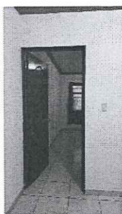
Acceso a la bodega electoral
