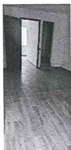
Acceso a la bodega electoral
