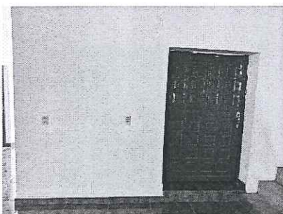
Acceso a la bodega electoral
