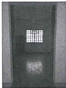
Acceso a la bodega electoral
