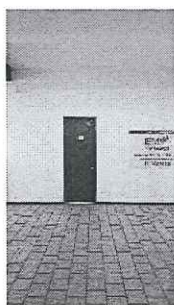
Acceso a la bodega electoral
