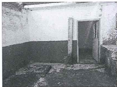
Acceso a la bodega electoral
