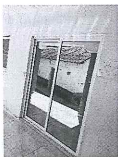
Acceso a la bodega electoral
