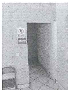
Acceso a la bodega electoral
