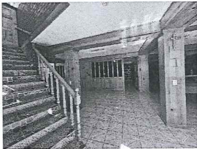
Acceso a la bodega electoral
