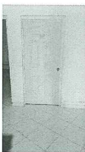
Acceso a la bodega electoral
