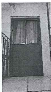
Acceso a la bodega electoral
